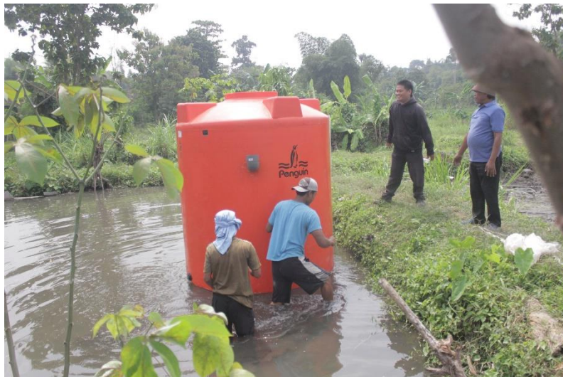
Gambar 2. Pemasangan Instalasi Unit Digester Biogas
