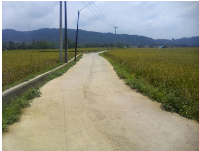
Gambar 3. Salah satu infrastruktur jalan di Desa Karehkel
