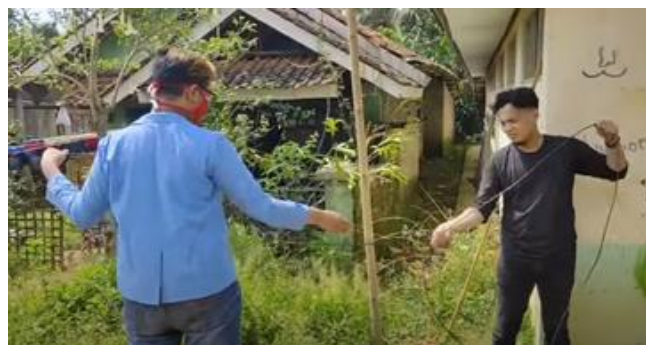
Gambar 3. Pemasangan Antena Penguat Signal 4G
