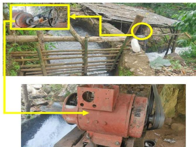
Gambar 1. Kondisi Generator-Mikrohidro di Dusun Batu Saeng
